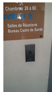
Commande palière du niveau principal
